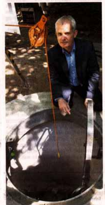
An der Tauchstation. Jens Feddern von den Wasserbetrieben an einem der verdächtigen Brunnen. Am Kabel hängt eine Kamera, die Bilder aus dem Rohr liefert. Foto: Paul Zinken
