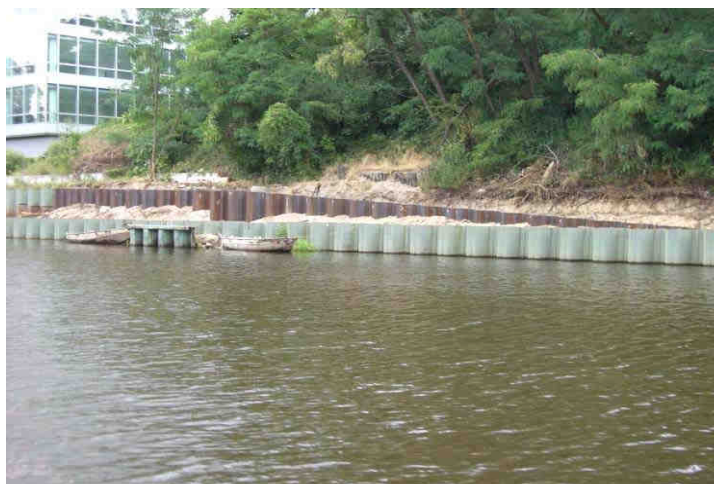
Abb. 5 Einleitungsbauwerk für Mischwasser aus Regenüberläufen, Quelle: privat
