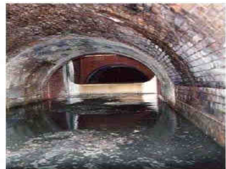
Abb. 4: Regenüberlaufwehr, Quelle: BWB
