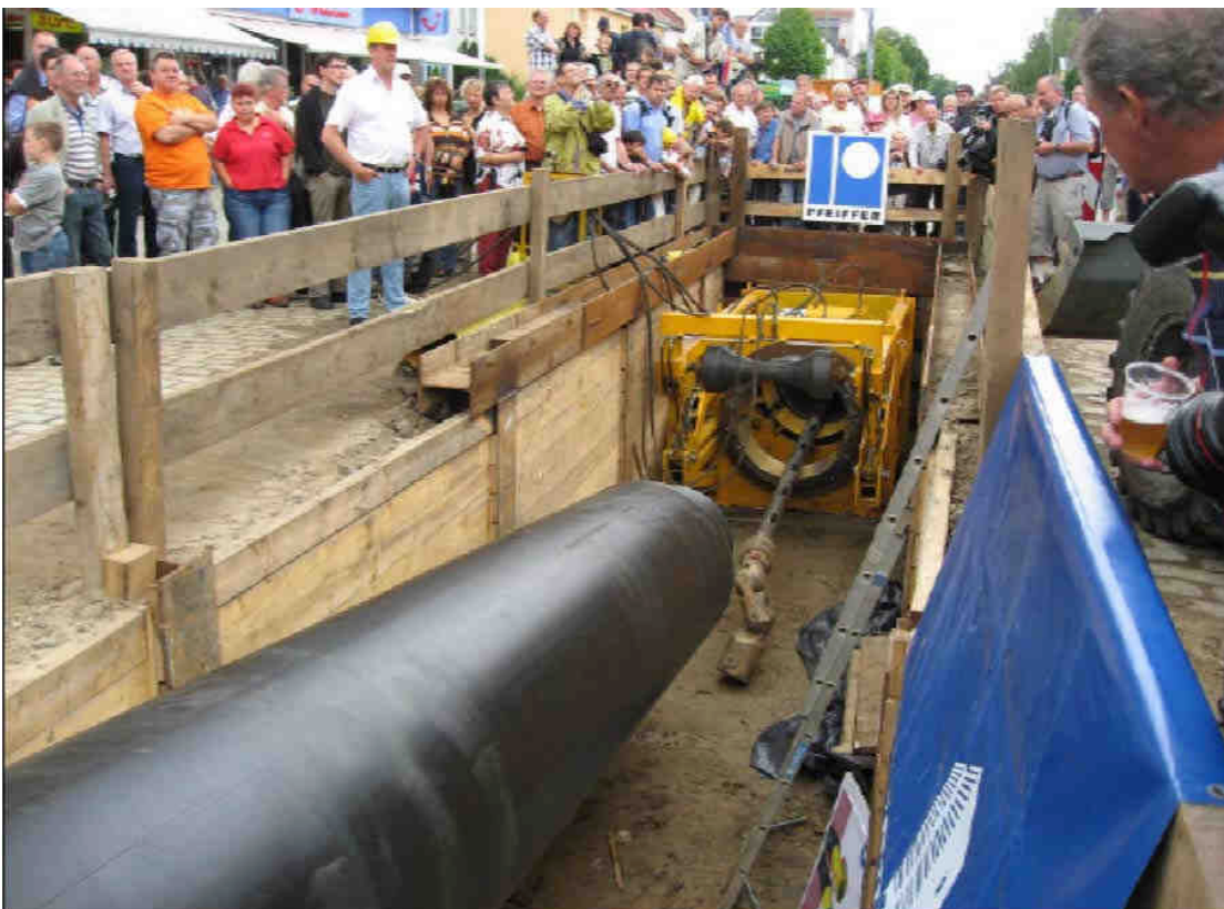
Abb. 33: Lining direkt vor dem Einzug
