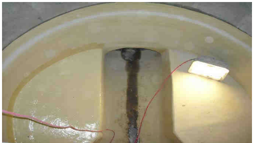
Abb. 9 und 10: Schachtbilder, Quelle: Firma Frisch & Faust Tiefbau GmbH
