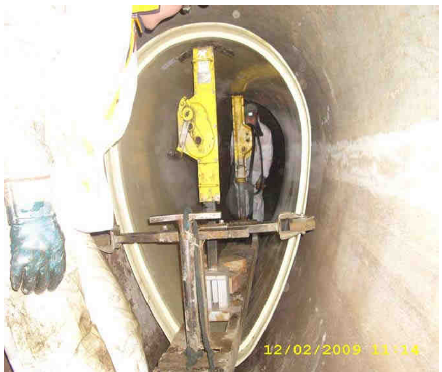
Abb. 19: Das Bild zeigt ein so genanntes Rohr-Relining zur Sanierung eines brüchigen Abwasserkanals mit Kurzrohren als Alternative zum Schlauchlining.
